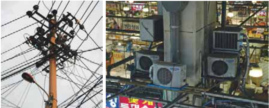
Abb. 12: Stromversorgung in einem Wohn- und Geschäftsviertel in Beijing (links), Fischmarkt mit vielen elektrischen Klimageräten in Seoul
