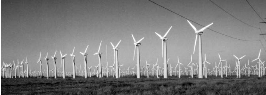
Abb. 9: Windfarm in Kalifornien mit 250-kW-Anlagen
