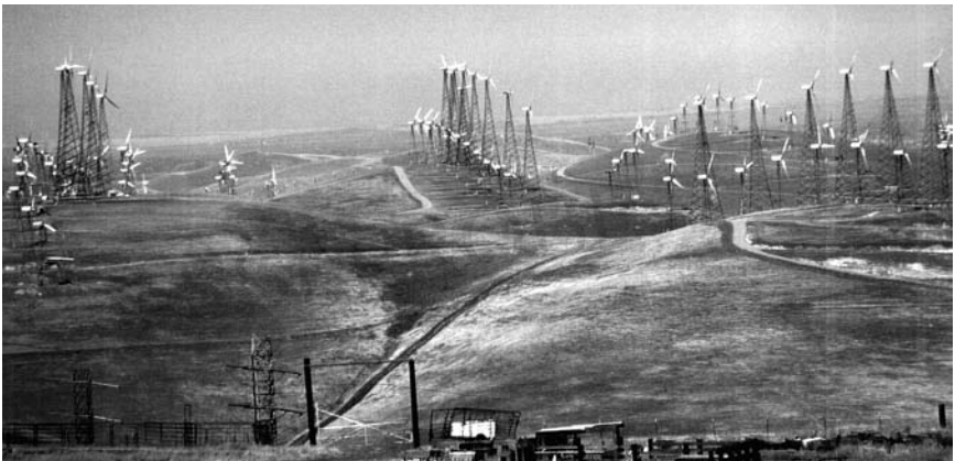
Abb. 8: Windfarm in Kalifornien mit Anlagen der 50-/100-kW-Klasse
