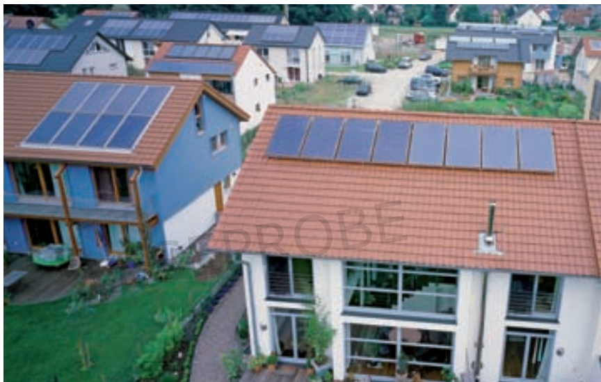
Abb. 2: Sonnenkollektoren für die Wärmeerzeugung (Solarthermie)
