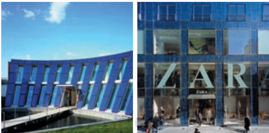
Abb. 3: Links: Das Bürogebäude der Firma Juwi mit PV-Fassade, rechts: Die polykristalline Solarfassade am Modehaus Zara in Köln.
