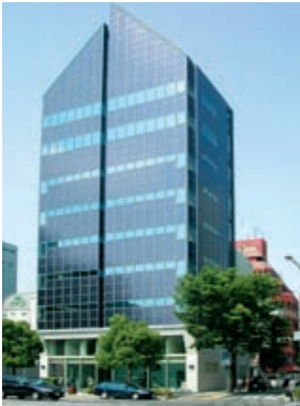
Abb. 5: Bürogebäude in der japanischen Stadt Kobe mit in die Fassade integrierten Solarmodulen
