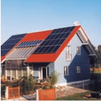
Abb. 4: Photovoltaik-Anlagen mit a) Auf-Dach-Montage, b) komplettes In-Dach-Montage-System
