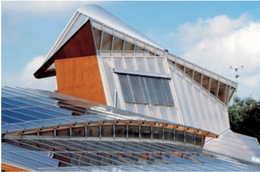
Abb. 2: Servicepavillon der Badeinsel Steinhuder Meer mit Photovoltaik-Modulen und solarthermischen Vakuumröhrenkollektoren
