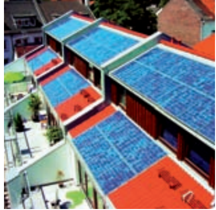
Abb. 4: Photovoltaik-Anlagen mit a) Auf-Dach-Montage, b) komplettes In-Dach-Montage-System
