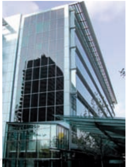
Abb. 6: Amorphe Photovoltaik-Module an der Fassade des Bayerischen Umweltministeriums
