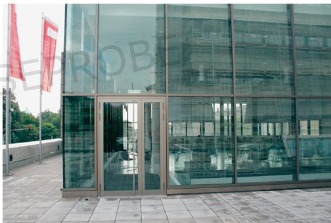
■ Abb. 27: Glasfassade mit Siebdruck als Sonnenschutz
