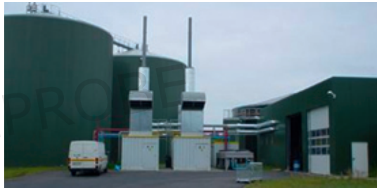
Biogasanlage mit BHKW
