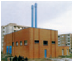
Heizkraftwerk mit 17 kW el
