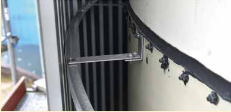
Abb. 2 Aufbau der Speicherwand: Das Verkleidungsblech ist über thermisch entkoppelte Edelstahl-Streifen mit den verschraubten Segmenten verbunden. Der Zwischenraum wird durch eine Polyurethan-Schüttung gedämmt.
