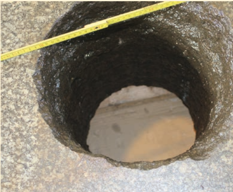
Abb. 4 Ein mit dem EIV-Bohrkopf gebohrtes Loch in einem Granitquader weist vergleichsweise glatte Bohrränder auf.
