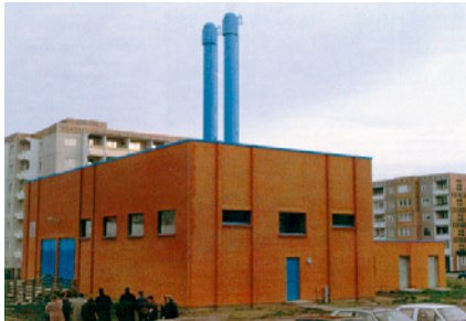
Heizkraftwerk mit 17\text{MW}_{\text{el}}
