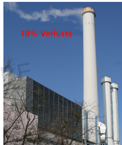
■ Abb. 22: Dampf-Heizkraftwerk mit geringen Verlusten
