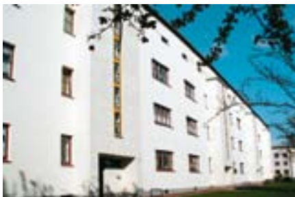
Abb. 9: Saniertes Gebäude der zwanziger Jahre
